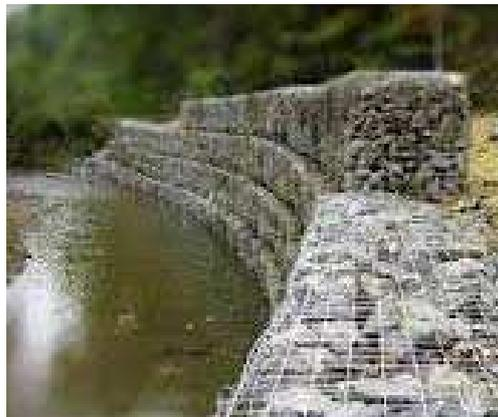
**Figura 117.** Muro de defensa con estructura gavionada.
