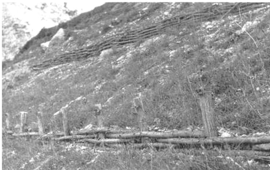
**Figura 112:** Sistema de palizadas en una ladera de alta pendiente. Fuente: Disponible en <http://www.fao.org/docrep/006/ad081s/AD081s03.htm>
