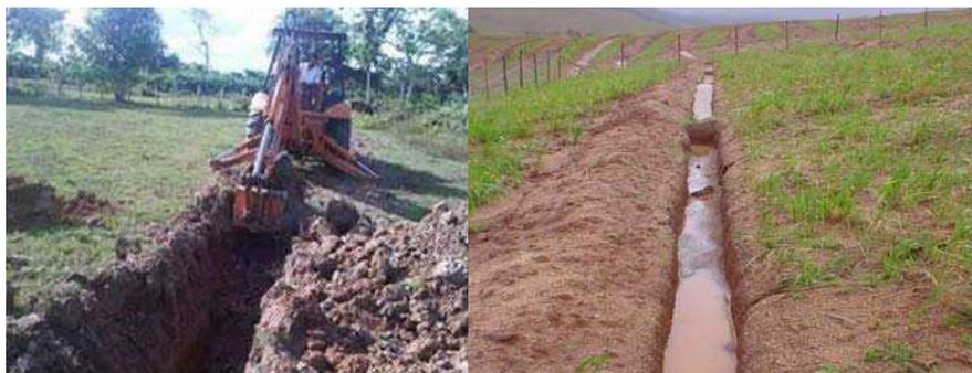
**Figura 111:** Retroexcavadora realizando una zanja de drenaje y zanja de drenaje finalizada. Fuente: Disponible en <http://es.paperblog.com/experiencia-prv-grupo-varber-781544> <http://eias.utralca.cl/Html/zanjas2.html>
