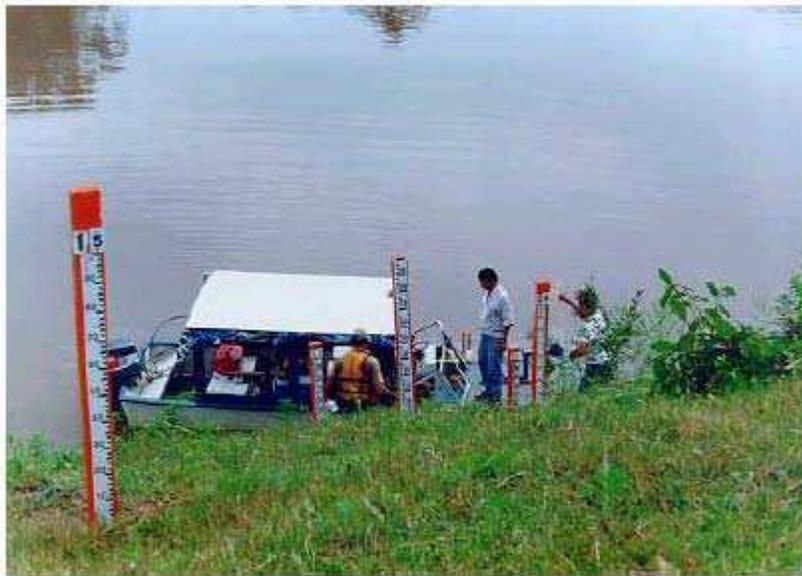
Foto 3.1 Instalación de limnímetros en el Río Atacuar- Estación Bocas.
