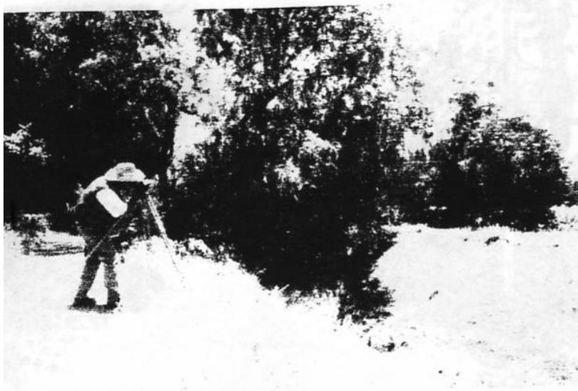
Figura 4.5 Muestra el momento en que la brigada topográfica obtiene la sección del cadenamiento 2+520.
